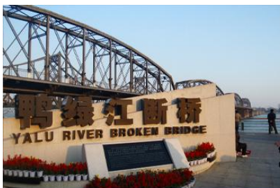
สะพานขาด
